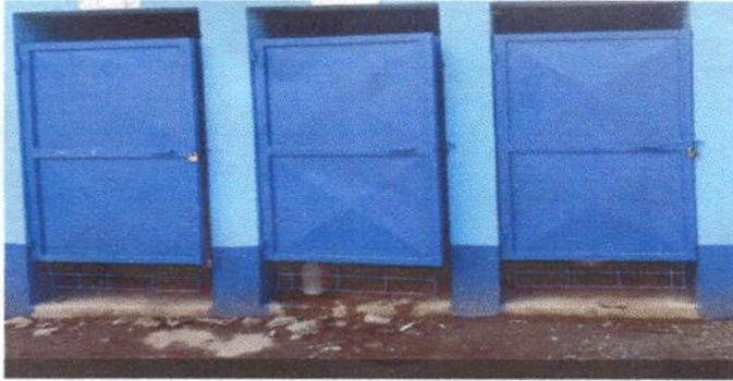
Foto 1: Mantenimiento a estructura (lijado, cambio de tubo, cepillado, sujeciones, aplicación de pintura) a puertas de metal, servicios sanitarios.
